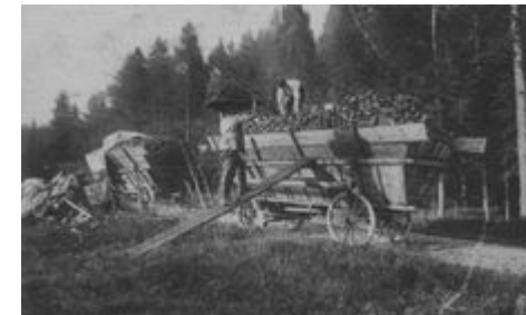
Le chargement du charbon de bois
