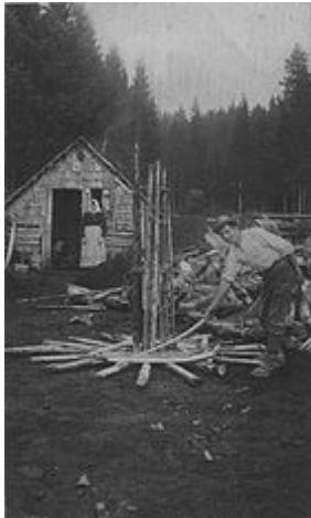
Constitution de la cheminée centrale
